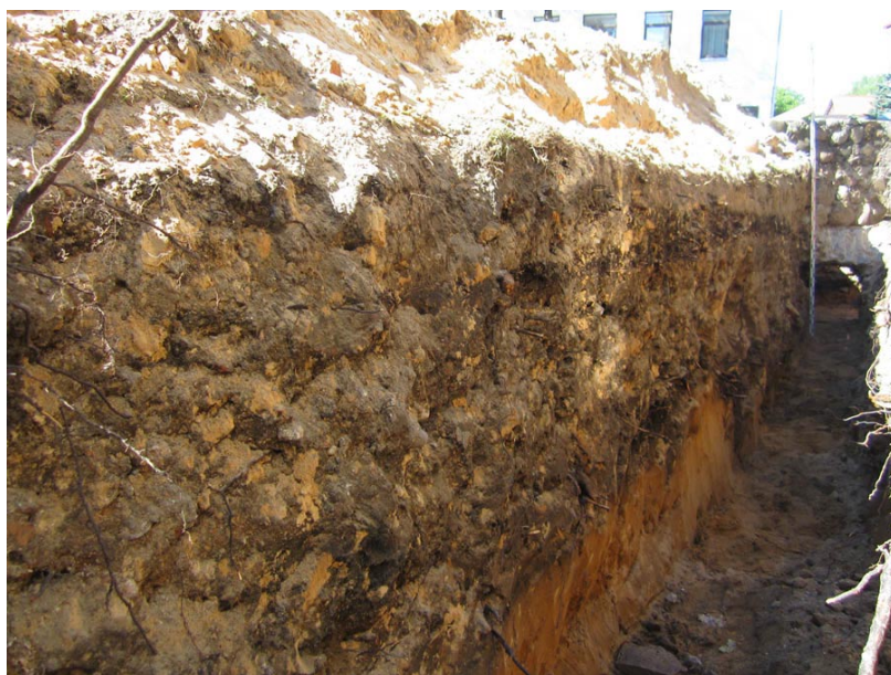
29. Perkasa 1, pietinės sienelės pjūvio fragmentas. Vaizdas iš šiaurės rytų.
