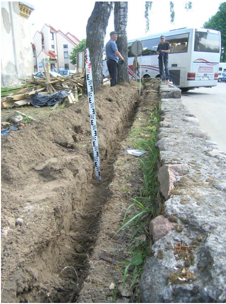
87. Tranšėja apšvietimo kabeliui pietrytinėje cerkvės šventoriaus dalyje. Vaizdas iš pietvakarių.
