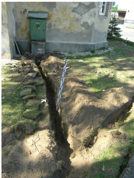
91. Tranšėja elektros kabeliui pietrytinėje cerkvės šventoriaus dalyje. Vaizdas iš pietryčių.
