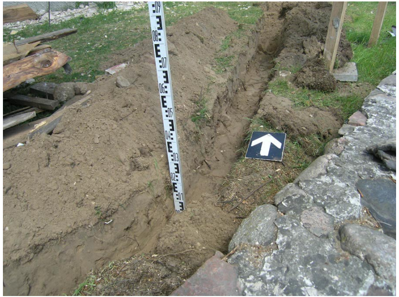
88. Tranšėja apšvietimo kabeliui rytinėje cerkvės šventoriaus dalyje. Vaizdas iš pietų.
