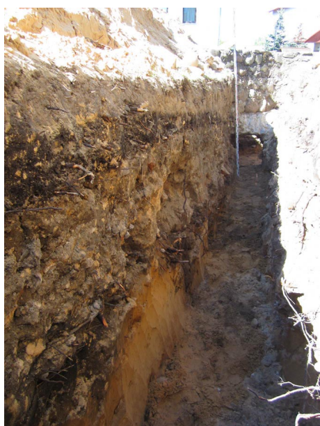
30. Perkasa 1, pietinės sienelės pjūvio fragmentas. Vaizdas iš šiaurės rytų.
