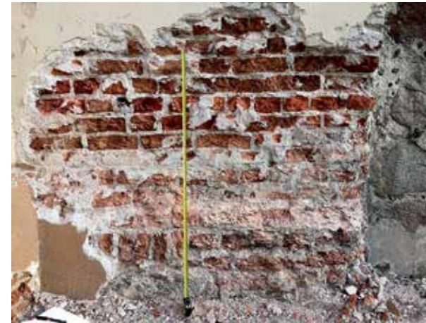
12 pav. Bažnyčios cokolinė dalis pašalinus tinką 2019 m. remonto metu. Nuotr. Ž. Buržinsko
