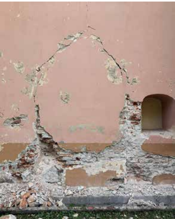
14 pav. 2019 m. bažnyčios remonto metu atidengti XIX a. antrojoje pusėje užmūryto šoninio bažnyčios įėjimo fragmentai. Dešinėje matoma niša, kurioje buvo laikomas šventintas vanduo. Nuotr. Ž. Buržinsko
